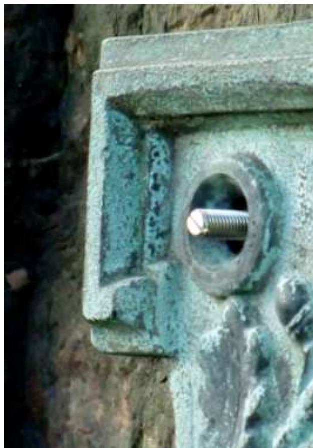
Der perfekt eingesetzte Gewindestab
